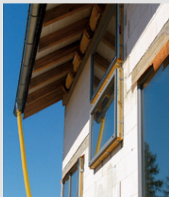
Předsazená montáž oken (Kalksandstein CZ s.r.o.)
