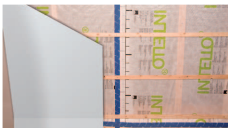
▲ Páska pro klima Tescon Vana a fólie Intello pro vzduchotěsné vnitřní konstrukce
