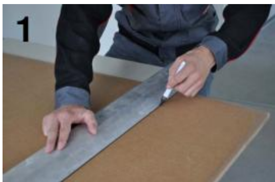
1 Zaměření a zakreslení potřebného rozměru desky
