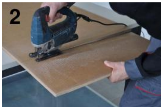
2 Formátování desky Wolf pomocí přímočaré pily. Další možností je použití kotoučové pily, rozbrušovačky nebo zalamovacího nože.
