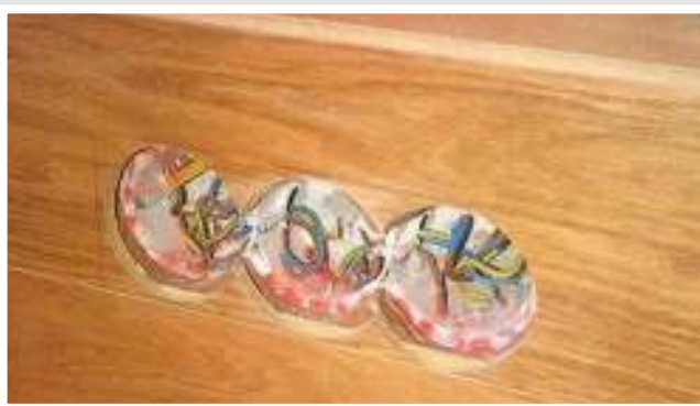
Detail instalační krabičky. Jako finální povrch byla zvolena dřevěná dýha celoplošně lepená k deskám Wolf.
