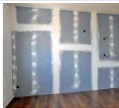
Podklad připravený pro závěrečnou malbu.
