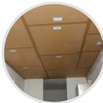
Montáž desek Wolf na žebírkový strop s podbitím z OSB desky. V případě, že je stropní konstrukce podbitá deskovým materiálem a dostatečně nosná, lze desky Wolf upevnit pomocí vrutů přímo na toto podbití.
