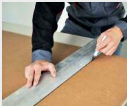
Zaměření a zakreslení potřebného rozměru desky.
